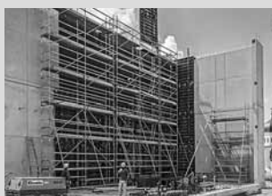
Pracovné lešenie na stavbách
