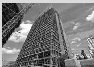
Pracovné lešenie fasádne
